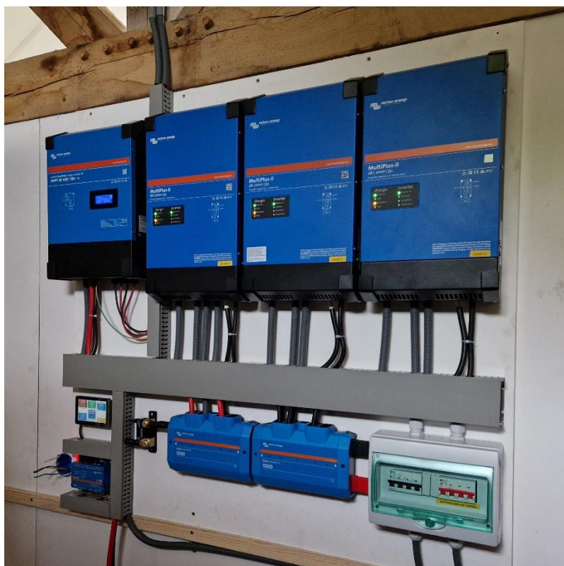
Figuur 3: Voorbeeld met 1 x MPPT lader en 3 x Multiplus 3000
