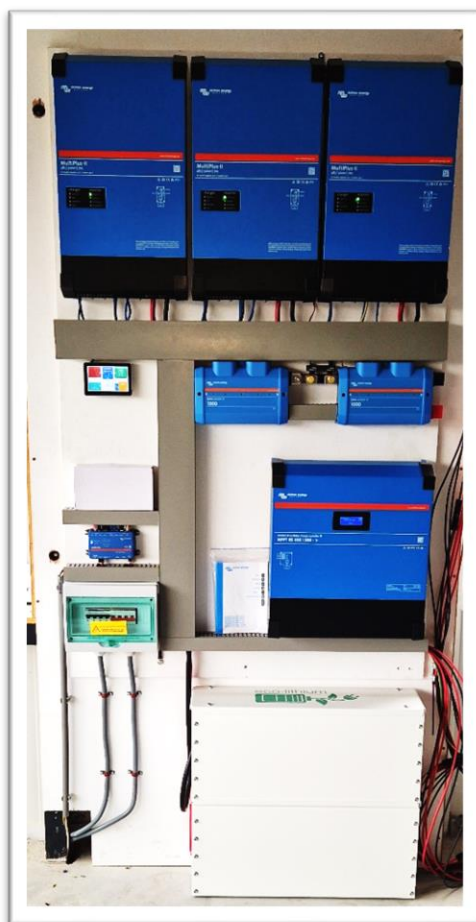
Figuur 11: Montagebord afmetingen: 1250 mm x 1040 mm x 180 mm (hxbxd)
