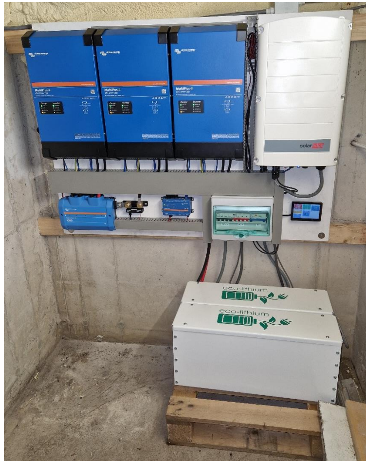
Figuur 12: Integratie met SolarEdge PV omvormer
