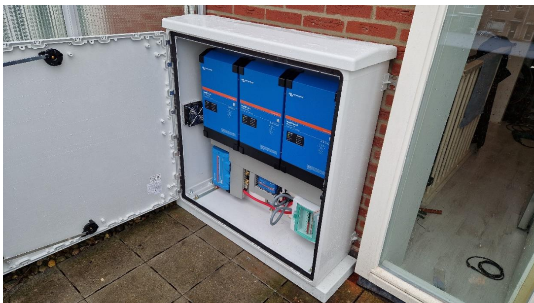
Figuur 13: Configuratie in gesloten buitenkast. Batterijen staan binnen ivm vorst beveiliging.
