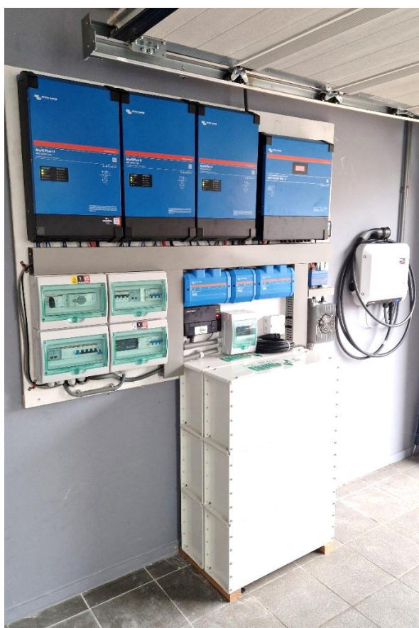
Figuur 5: 3x5kVA omvormer met MPPT lader en Enphase omvormers. Opslag capaciteit is 3x14kWh, opgesteld in een garage.
