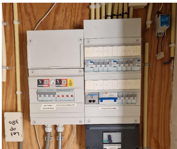
Figuur 10: uitbreiding groepenkast met extra meters en automaten
