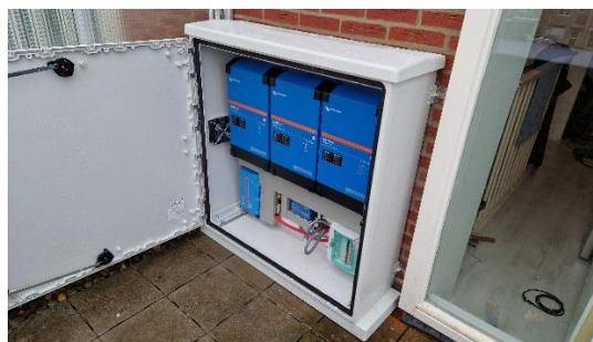
Figuur 3: Configuratie in gesloten buitenkast. Batterijen staan binnen ivm vorst beveiliging.
